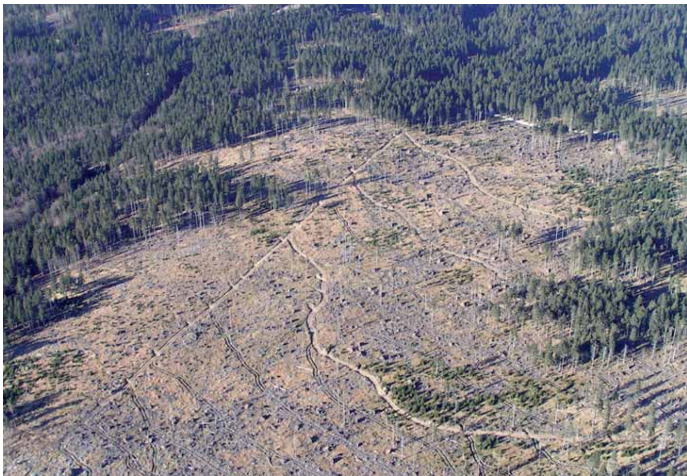
Obr. 9: Při vyklizení plochy dochází k masivnímu zásahu do přirozených procesů. Na fotografii jsou zřetelné hluboké rýhy, způsobené vyvážáním dřeva. Foto: Franz Baierl
